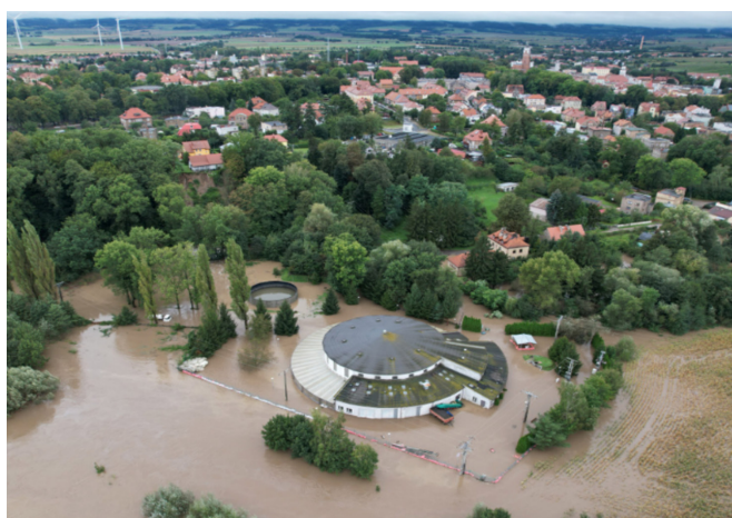
Rys. 1. Widok na zalaną Miejską Oczyszczalnię Ścieków w Paczkowie (ZWIK Paczków)
