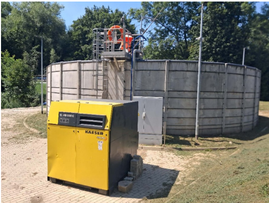
Rys. 7. Reaktor SBR adaptowany na bazie zbiornika retencyjnego (ZWIK Paczków)
