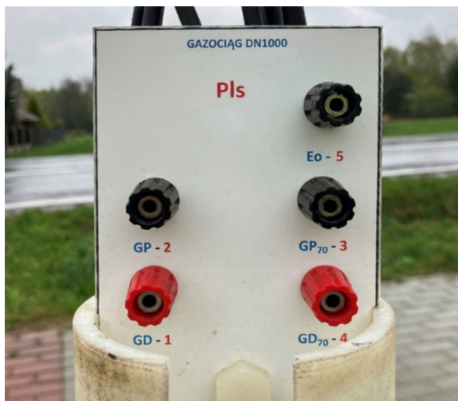
Rys. 11. Pomiar spadku napięcia (materiały GAZ-SYSTEM)
