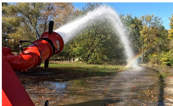
Rys. 7. Stanowisko ogniowe wykorzystane do oceny działania automatycznego systemu gaśniczego. Źródło: opracowanie własne Fig. 7. Fire test stand used during the evaluation of the automatic fire suppression system. Source: authors' own study
