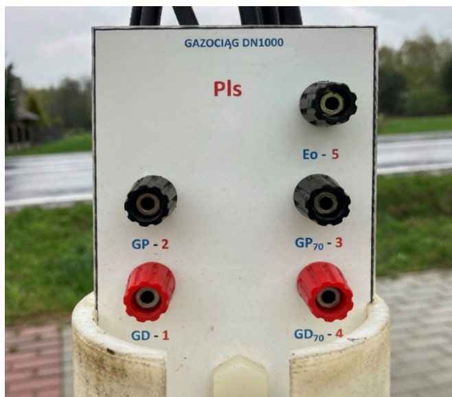
Rys. 11. Pomiar spadku napięcia (materiały GAZ-SYSTEM)
