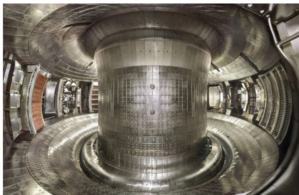
Rys. 5. Widok komory reaktora fuzyjnego [5] Fig. 5. View of the fusion reactor chamber [5]
